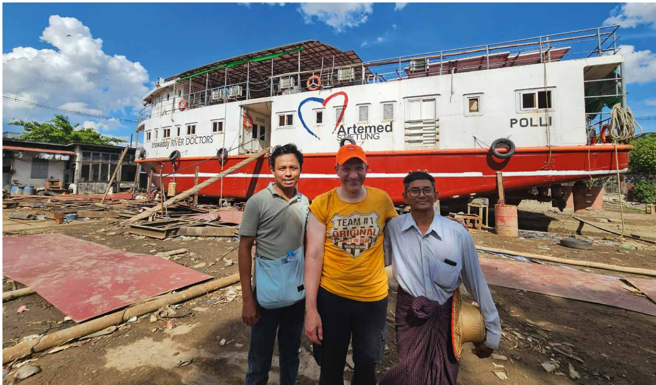
Klaus Strätz und das Team installieren die neue Wasseraufbereitungsanlage
