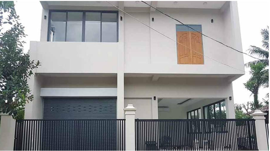
Trotz Corona Lockdown und Militärputsch wurde das Gebäude innerhalb eines Jahres fertiggestellt
